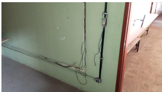
Foto 32 – Instalações elétricas avariadas.
