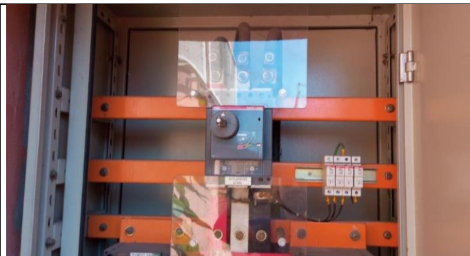
Foto 21 – Disjuntor geral QGBT.
