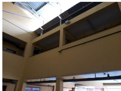
Foto 12 – Cobertura do pátio interno da escola. Possível local de acesso dos pombos.
