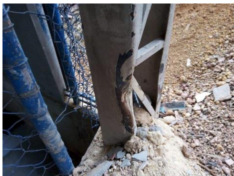
Foto 45 – Vista da treliça vertical de sustentação das treliças da cobertura.
