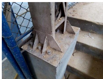
Foto 40 – Vista da base chapa de base e sua fixação na base de concreto.
