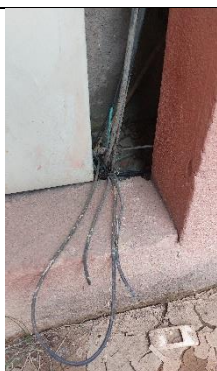
Foto 23 – Cabos alimentadores danificados proveniente de furto.
