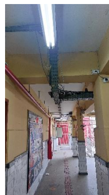
Foto 26 – Eletrocalha avariada, vista do corredor principal de saída.
