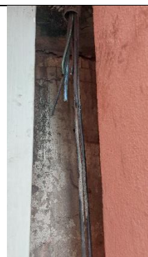
Foto 24 – Cabos alimentadores danificados proveniente de furto.
